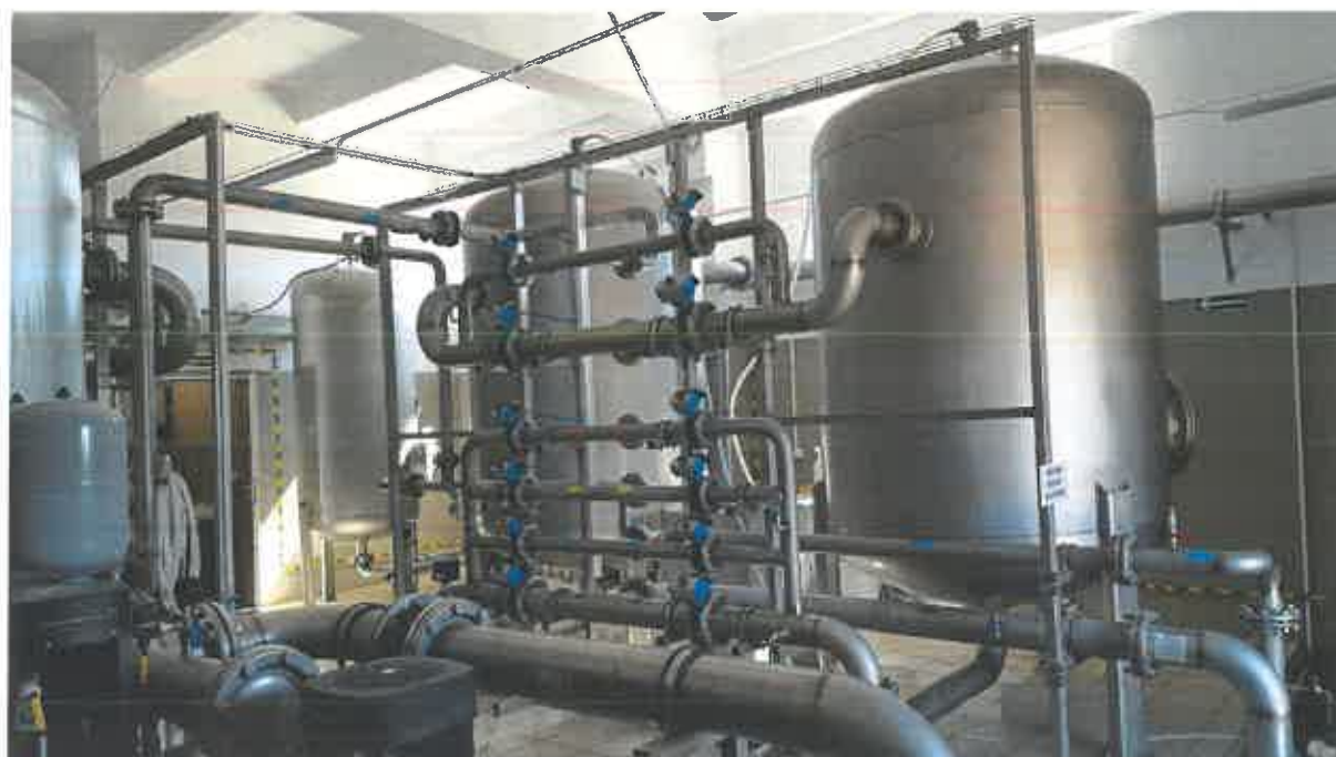
Zdjęcie 16. Przebudowa stacji uzdatniania wody w m. Brzeźnica – wygląd wewnętrzny budynku, hala technologiczna
