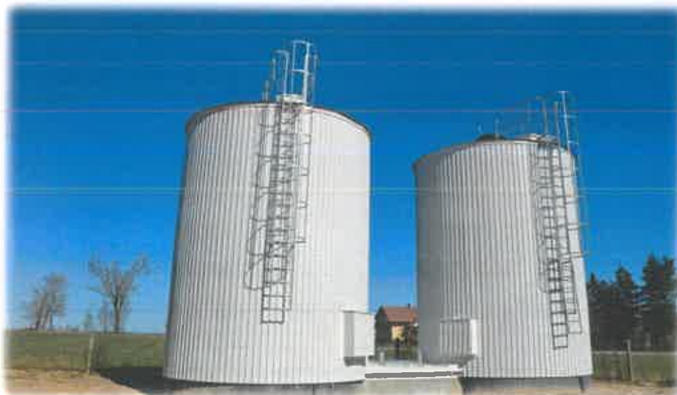
Zdjęcie 18. Budowa/przebudowa stacji uzdatniania wody w m. Domanowo - zbiorniki wyrównawcze
