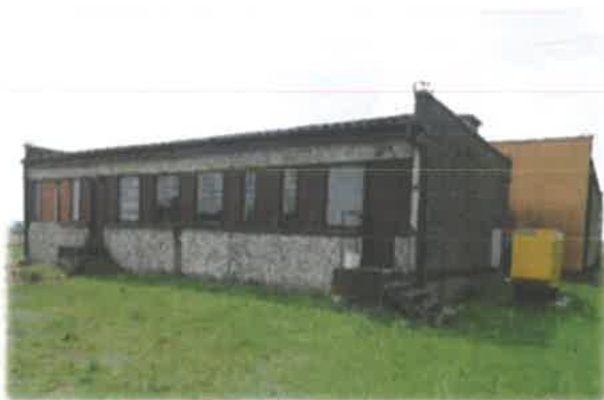
Zdjęcie 14. Stacja uzdatniania wody w Brzeźnicy przed przebudową
