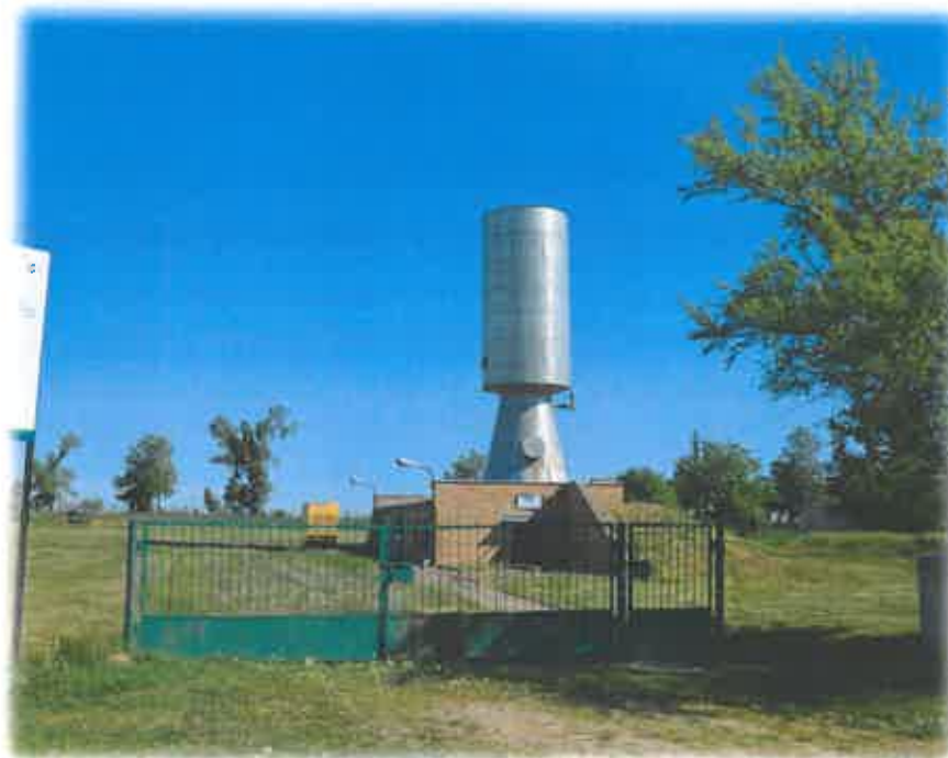
Zdjęcie 13. Stacja uzdatniania wody przed budową nowego budynku w Domanowie
